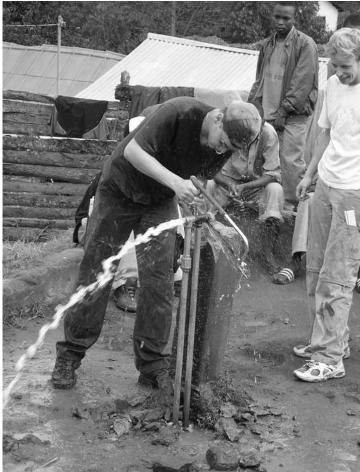
Reparaturen an der Hauptleitung
