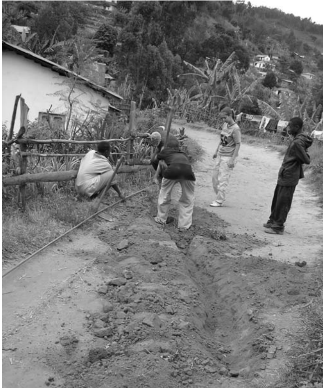
Ausheben für die neuen Wasserleitungen
